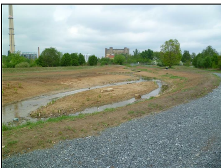
Abb. 1: Vor der Maßnahme: bestehende ungesteuerte Flutmulde, 07.05.2012
